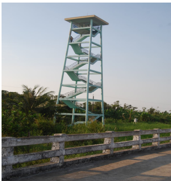
Xây dựng chòi canh lửa
